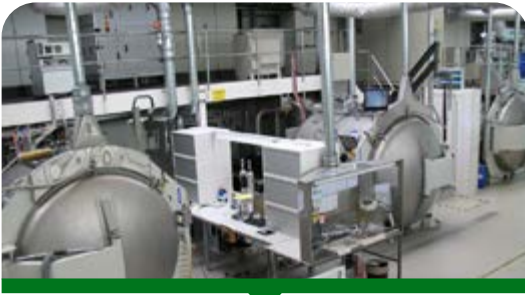
Machines de production des revêtements VPS
